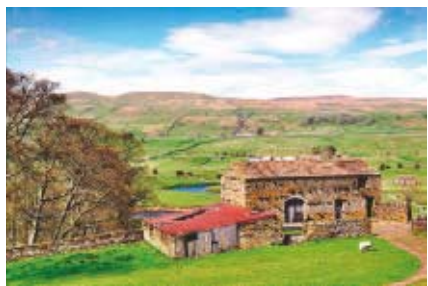
4| Alte Scheune vor rauer Kulisse. Die flachen Hügelkuppen sind typisch für die Gegend.
